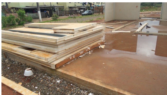
Foto 3: obras ID 19874, Gravataí/RS, em 20 de agosto de 2015.
