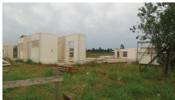
Foto 4: obra ID 24615, Gravataí/RS, em 26 de agosto de 2015.
